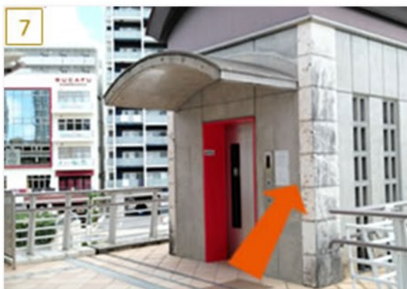
⑦ 荷物の多い方は奥のエレベーターをご利用下さい。
